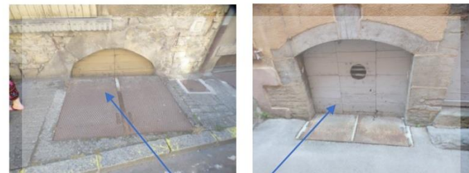
Ouvertures de caves et protection métallique de descente de cave d'emprise plus ou moins importante
