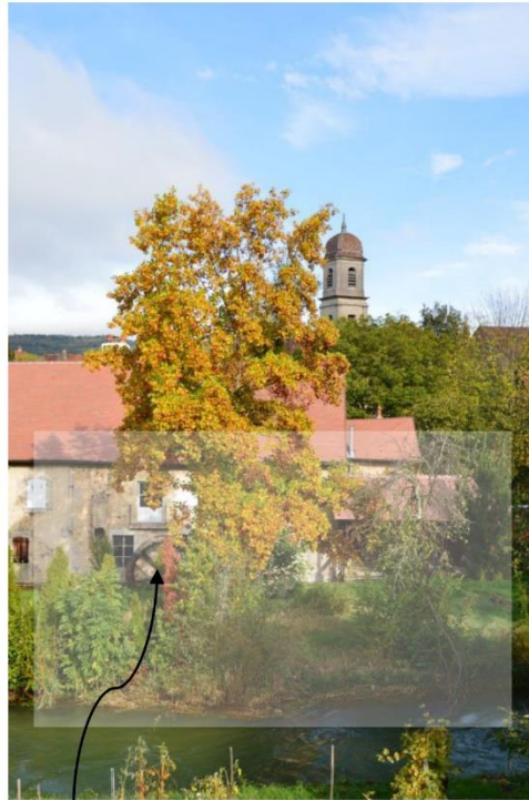
Les roues encore en place en bois ou en métal
