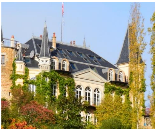
Percements excessif château des Tourillons
