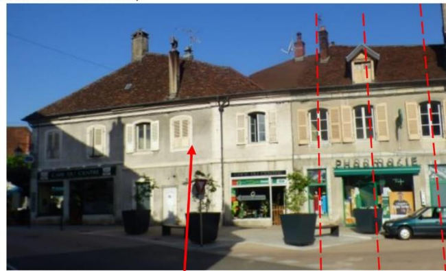
Les maçonneries sont en moellon enduit et les baies portent des persiennes battantes aux étages
