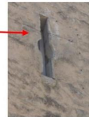
Trace de rempart avec percement défensif et différence de maçonnerie
