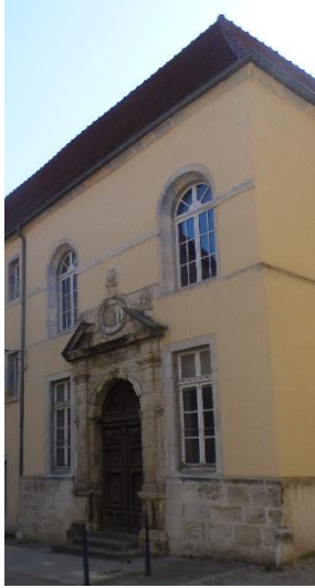
Portail de l'ancienne chapelle du couvent (5)
