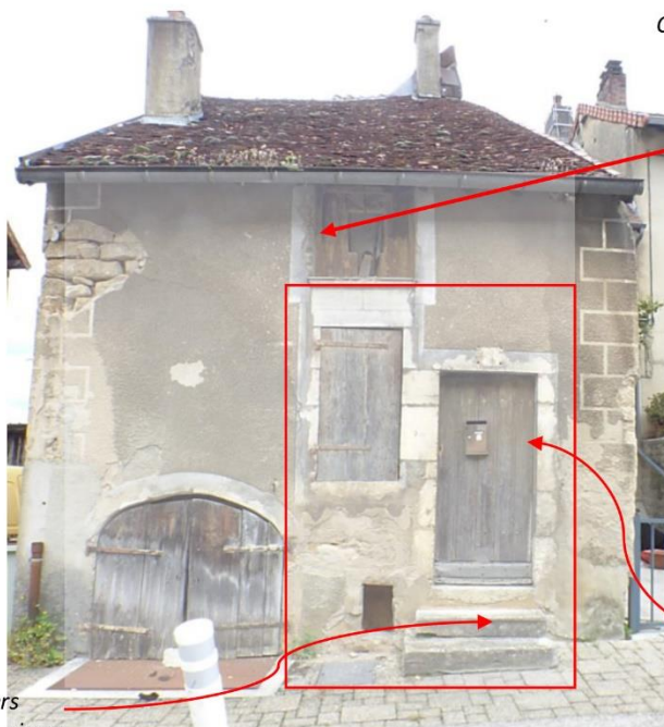
Des fenêtres sous toiture de forme presque carrée, ancienne lucarne passante
