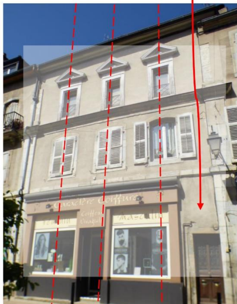
Grande rue, probable surélévation mais qui a conservé l'ordonnement de la façade et l'équilibre des percements
