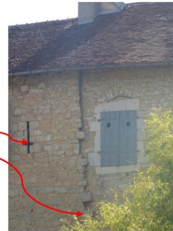
Trace de rempart avec percement défensif et différence de maçonnerie
