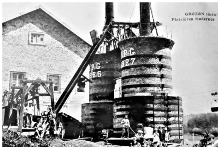
Mine de gypse de Grozon. À gauche, chargement des wagonnets avec les blocs de gypse. À droite les fours destinés à déshydrater partiellement le gypse. L'eau représente 21 % de cette pierre et c'est par sa déshydratation partielle lors d'une cuisson qu'on obtient le plâtre, une fois réduit en poudre. Collection D. Greusard.
