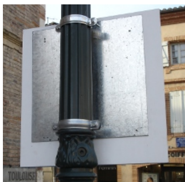
Fixation sur poteau par collier de serrage ou vissage directement sur le poteau
